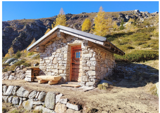
Foto n. 15 - Ricovero tradizionale in pietra ristrutturato nel 2025 da maestranze del Servizio Foreste PAT in loc. Laghi della Bella Venezia, Bieno. (R. Dalledonne - Archivio Servizio Foreste PAT)
