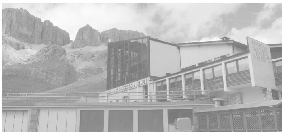
Figura 8 Stazione di Valle della Funivia del Sass Pordoi
