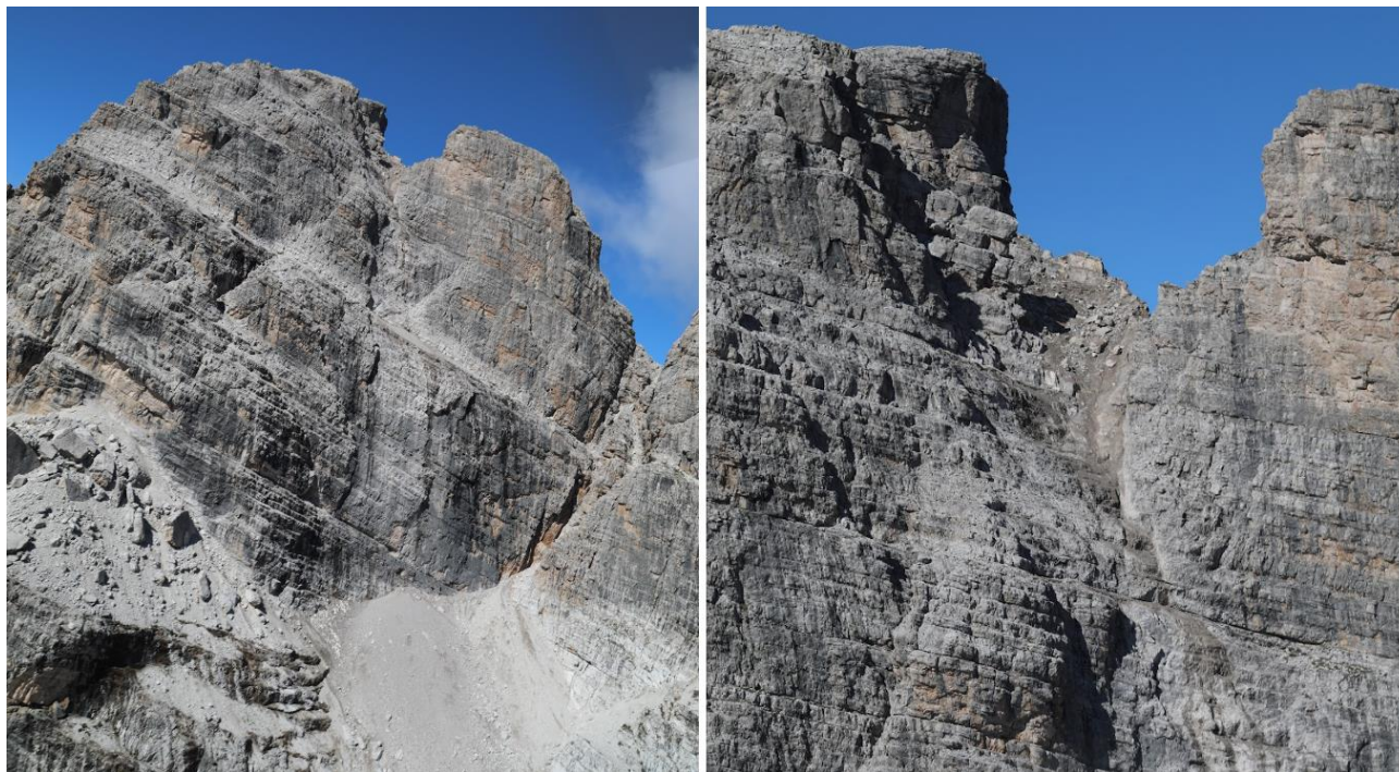
Figura 34: Parete est di Cima Falkner, tagliata dalla cengia su cui passa il Sentiero Benini. A destra: Particolare del materiale potenzialmente instabile.
