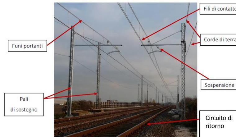
Figura 48 - Componenti principali linea a 3 kVcc
