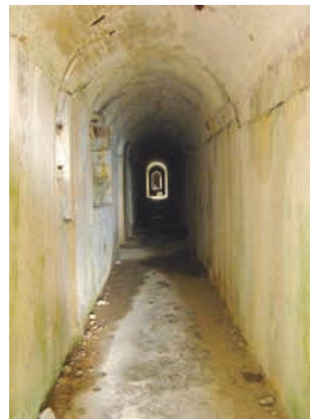
Galleria di accesso alle postazioni di artiglieria.
