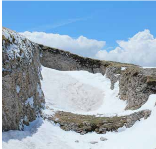
Lo scavo delle fondamenta del forte che gli austriaci volevano realizzare sulla cima della montagna
