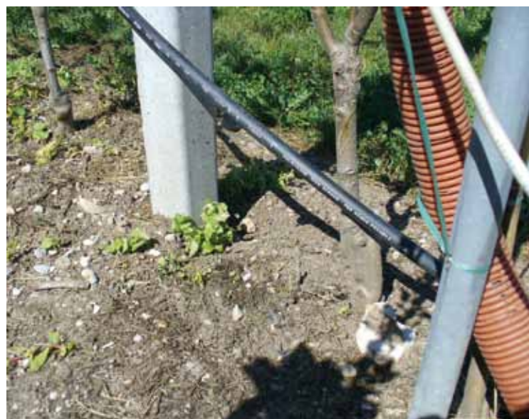
Il telecontrollo consentirà un ulteriore risparmio d'acqua
