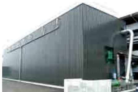
In alto: Particolare del reattore anaerobico
