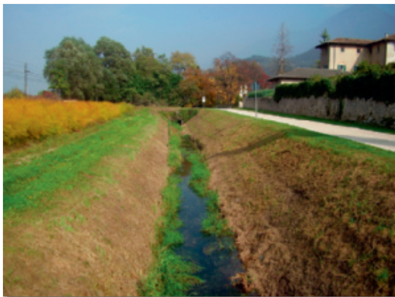
Un tratto della fossa Acquaviva
